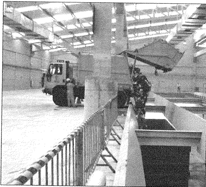
Figura 6 - Estação de transbordo – realizada direto no veículo transportador.
