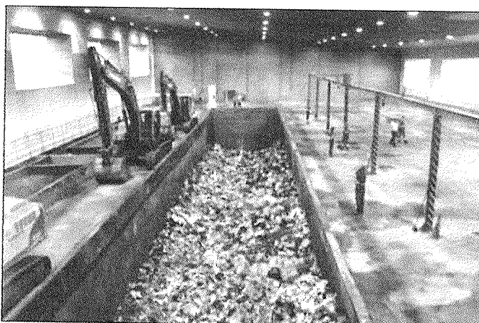
Figura 4 - Estação de transbordo com fosso de acumulação e uso de escavadeiras para destinação dos resíduos.
